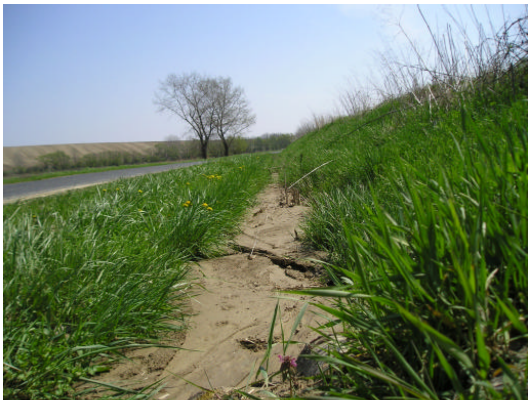
10. kép. Bonnya és Kisbárapáti közötti muút feltöltodött vízelvezeto árka, a Bárány-domb északi lábánál
